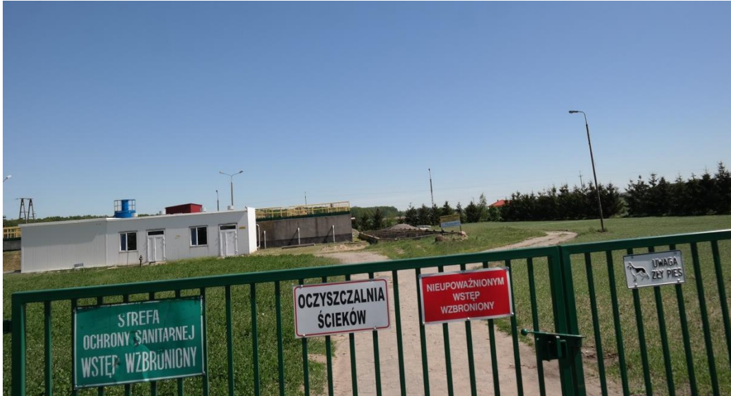
Zdjęcie 23. Oczyszczalnia ścieków w Osiecinach
