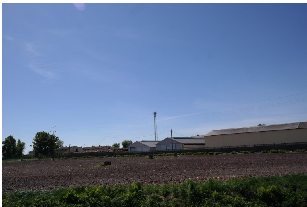
Zdjęcie 26. Ośrodek hodowli zarodowej w Osieczinach – budynki gospodarcze
