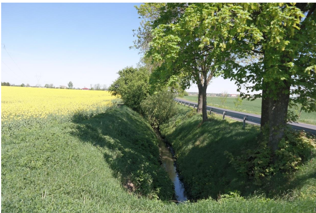
Zdjęcie 18. Przydrożny rów odwadniający przy drodze powiatowej 2815 C
