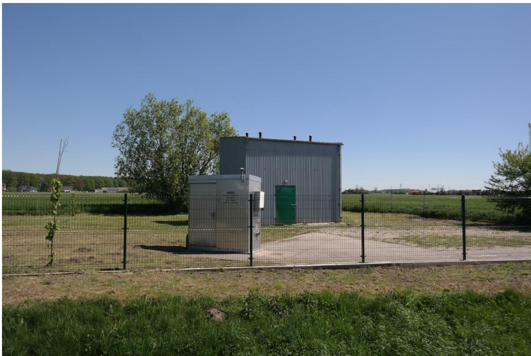
Zdjęcie 24. Przepompownia ścieków w Osiecinach
