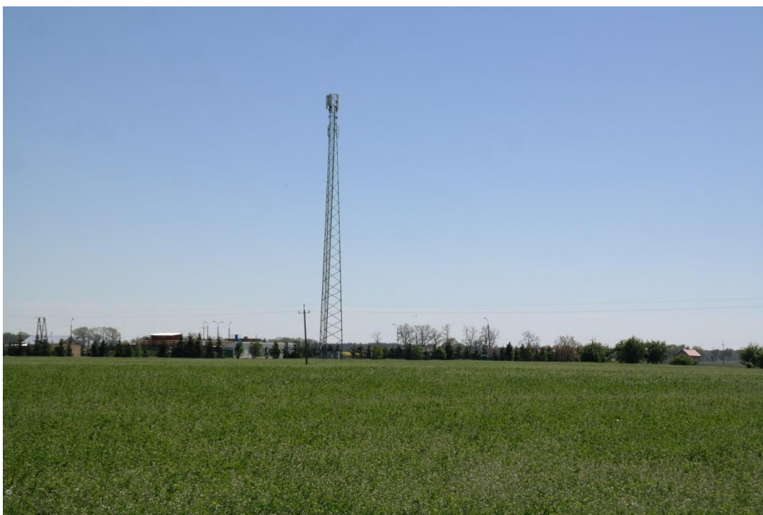
Zdjęcie 22. Maszt telefonii komórkowej oraz teren oczyszczalni ścieków w Osięcinach
