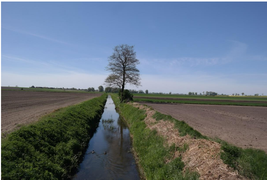
Zdjęcie 3. Kanał Bachorze
