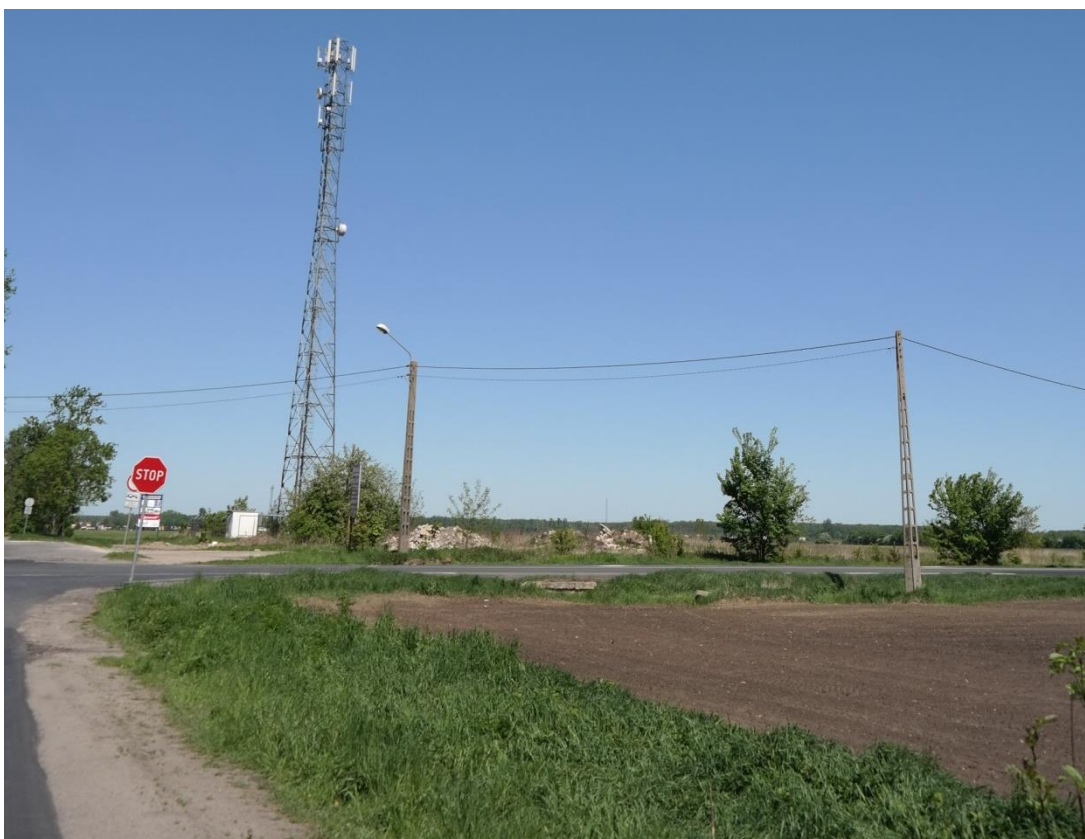
Zdjęcie 30. Maszt telefonii komórkowej u zbiegu dróg – krajowej nr 62 oraz wojewódzkiej nr 267 w miejscowości Samszyce
