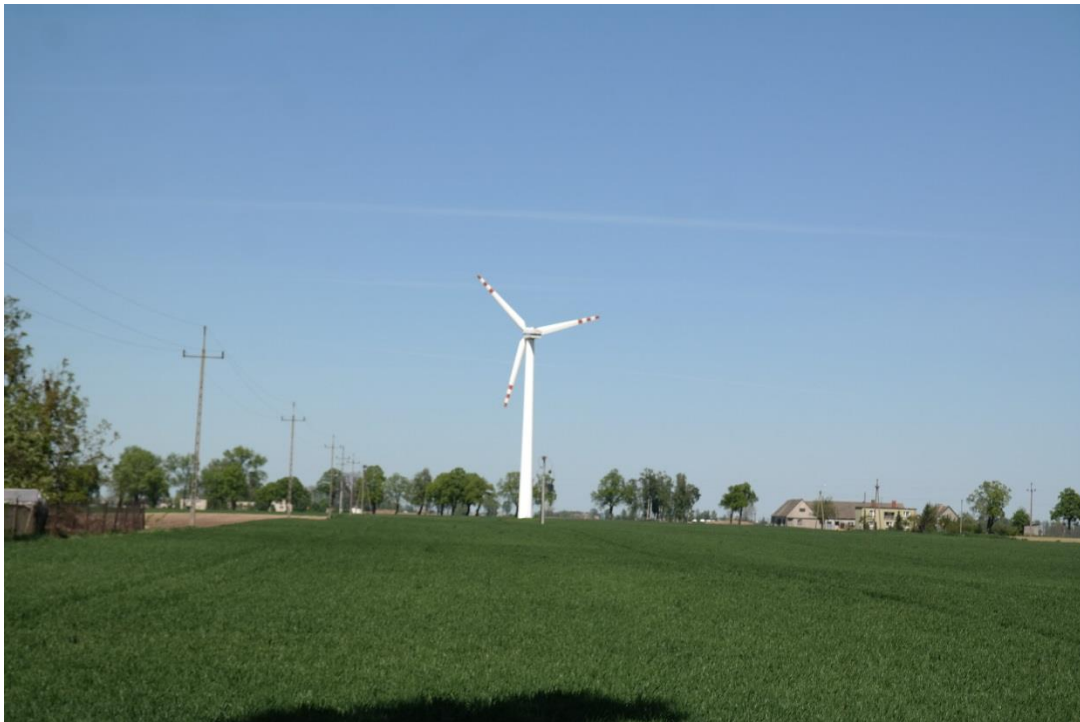
Zdjęcie 9. Elektrownia wiatrowa w miejscowości Belszewo
